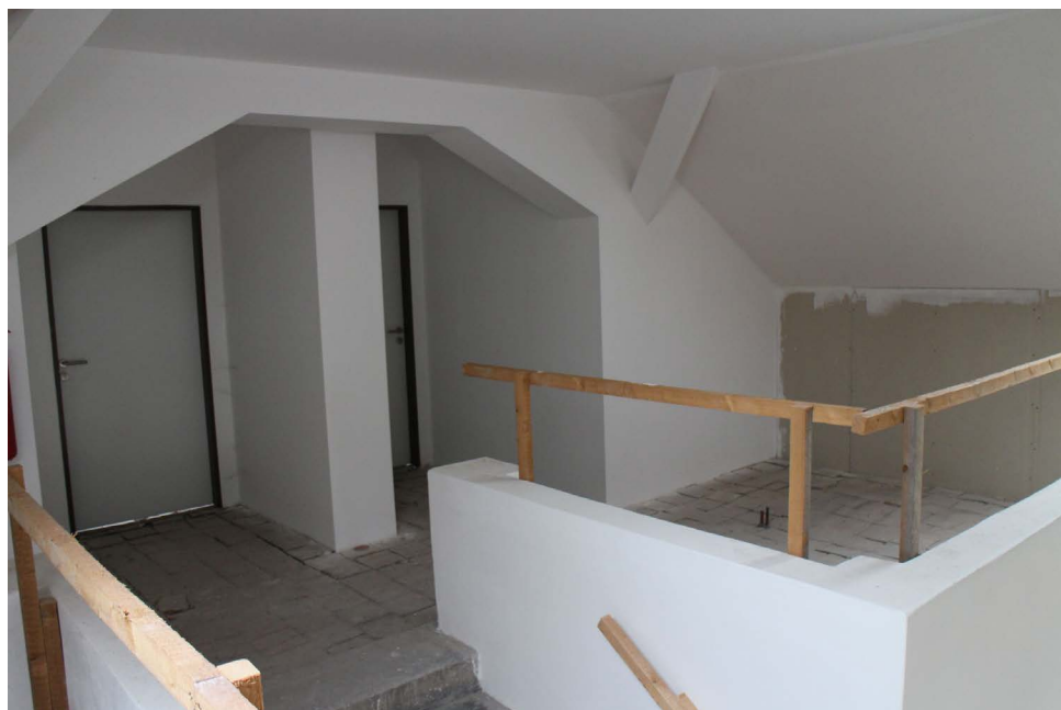
▼ Fotografie prostor před rekonstrukcí podkroví školy
